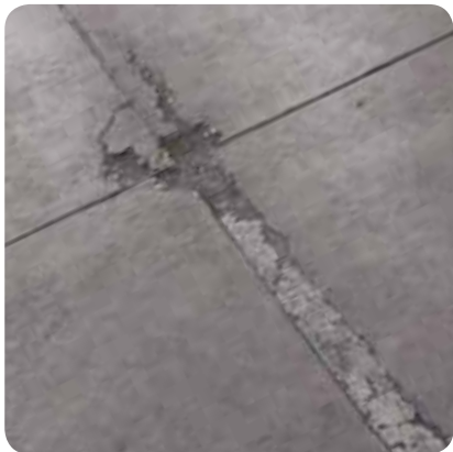
Uszkodzenia dylatacji
