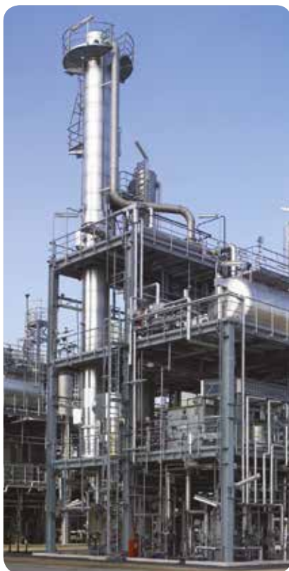
Ochrona stalowych konstrukcji
